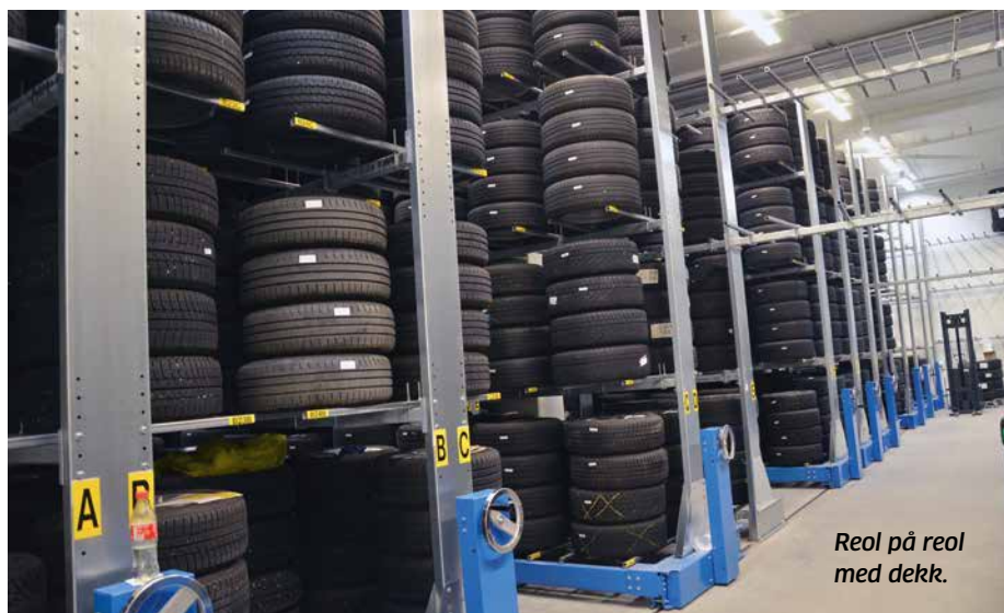
Det er rommelige og gode arbeidsforhold i det nye bilanlegget – også for dekkarbeid.
